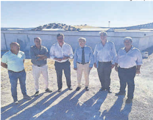
Autoridades junto al depósito reformado en Puente Genil.
